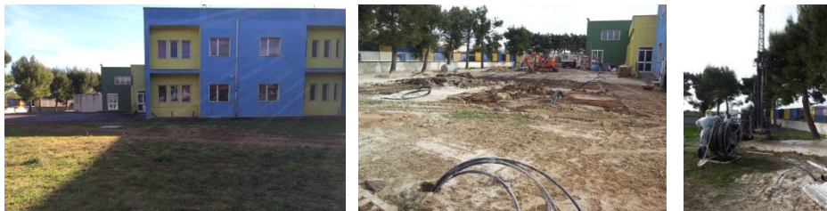
Istituto comprensivo, Melpignano (LE) | ristrutturazione 2014
